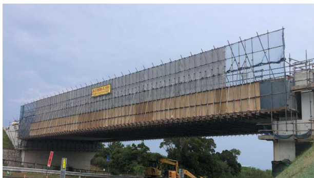
全景：施工前(南側橋梁)
