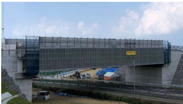
全景：施工前(北側橋梁)
