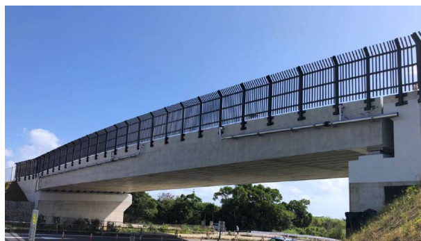
全景：施工後(南側橋梁)
