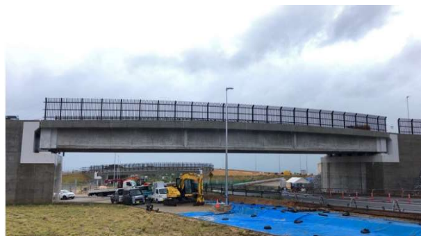
全景：施工後(北側橋梁)
