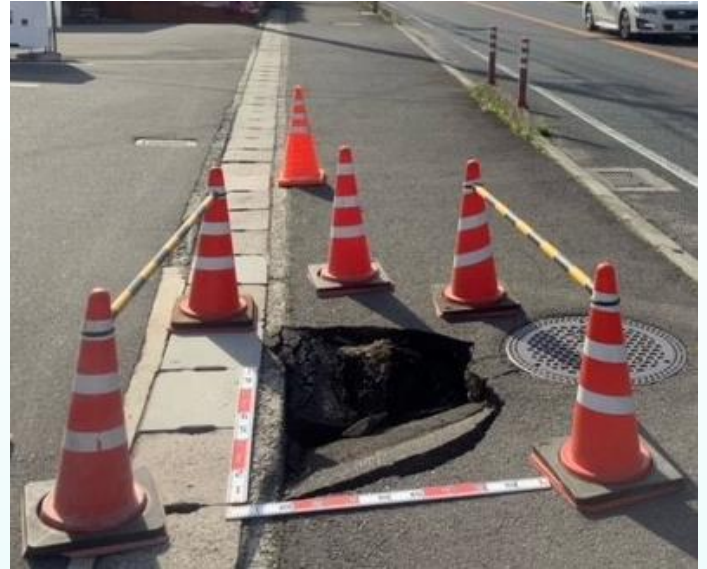
地下埋設物に起因する歩道の陥没
