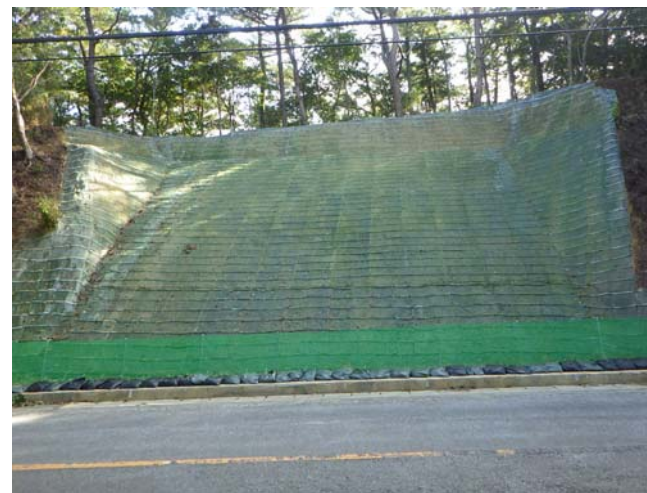
正面部 工事状況写真
