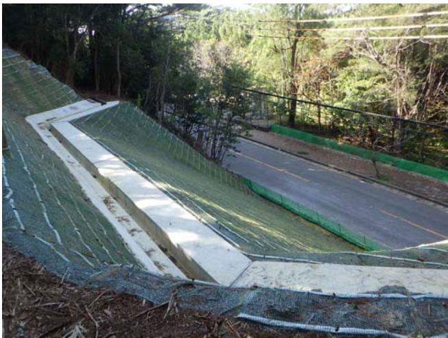
頭部 工事状況写真
