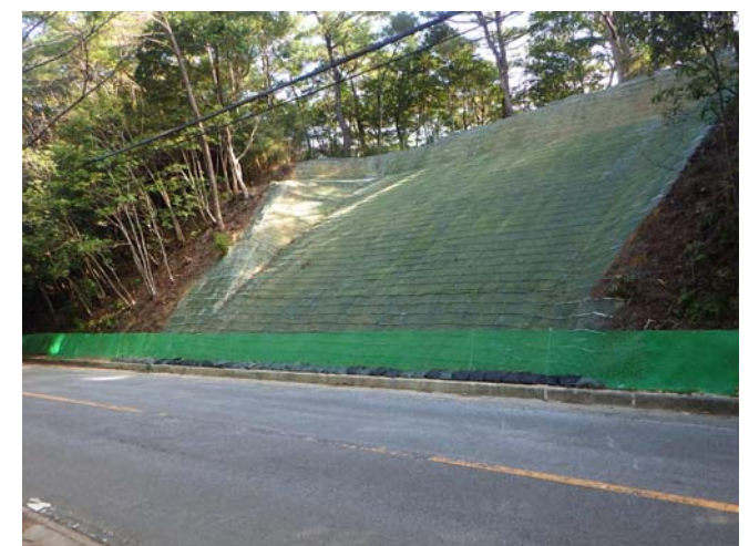
終点部 工事状況写真
