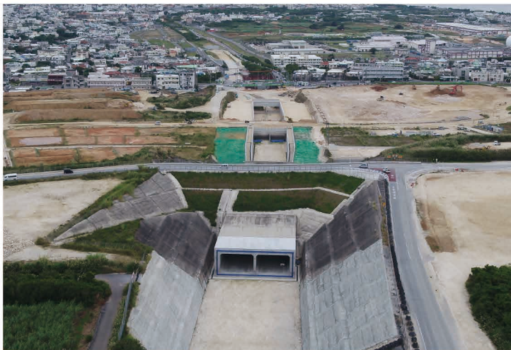
読谷道路(トンネル函渠工)
