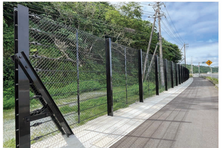
58号名護数久田防災対策(落石防護工)
