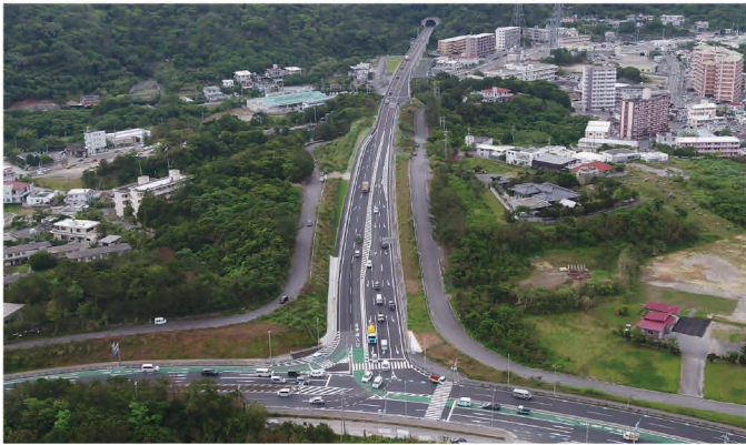
▲起点：伊差川IC 交差点改良工事
