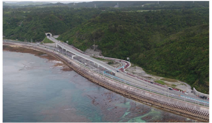
▲終点：数久田IC 数久田オンランプ橋は、国道58号（世富慶～許田）を夜間全面通行止め（3回）にして、多軸式特殊台車による桁運搬・架設を一括で行いました。（県内初）
