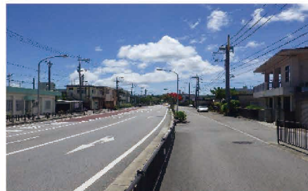
漢那地区電線共同溝
