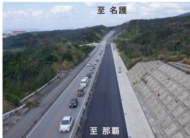
▲恩納南バイパス改良区間
