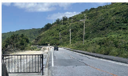
国頭地区歩道整備
