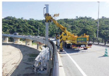
橋梁点検状況
