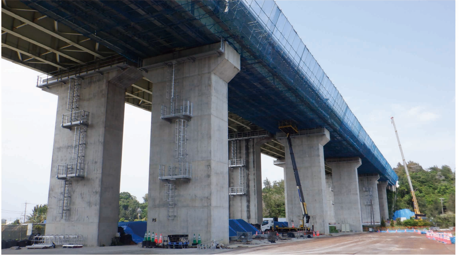
恩納バイパス(5号橋上部工)
