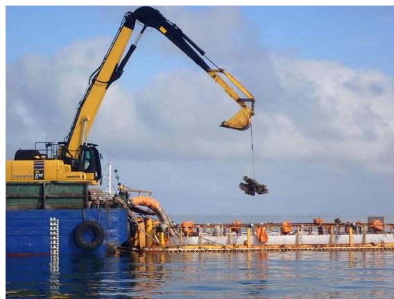
図 3-6 バックホウを使用した濁りが発生しない浚渫方法（岩盤吊り上げ）
