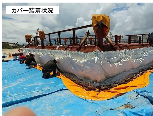
図 3-10 汚濁防止膜下部のウエイトチェーンカバー
