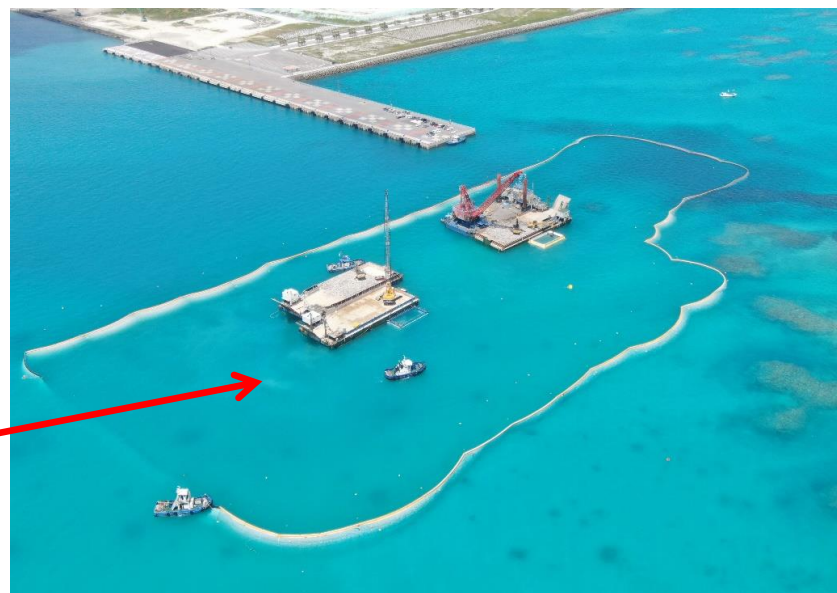
② 新港防波堤 令和3年8月
