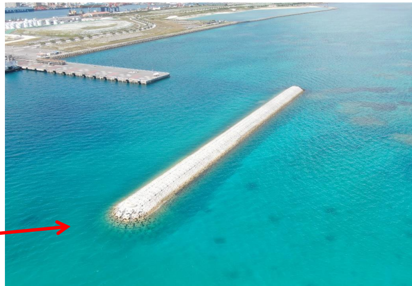
② 新港防波堤 令和4年8月
