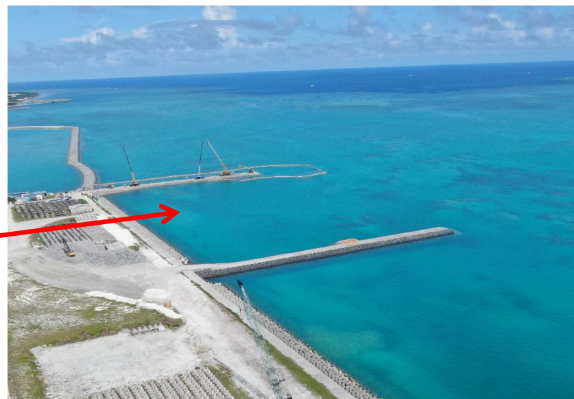
② 土砂処分場 令和5年8月
