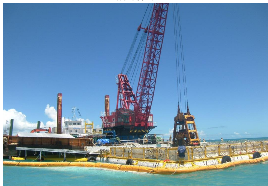
グラブ浚渫状況
