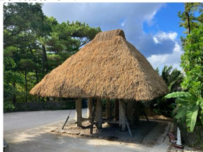
奄美の高倉茅葺き屋根補修状況
