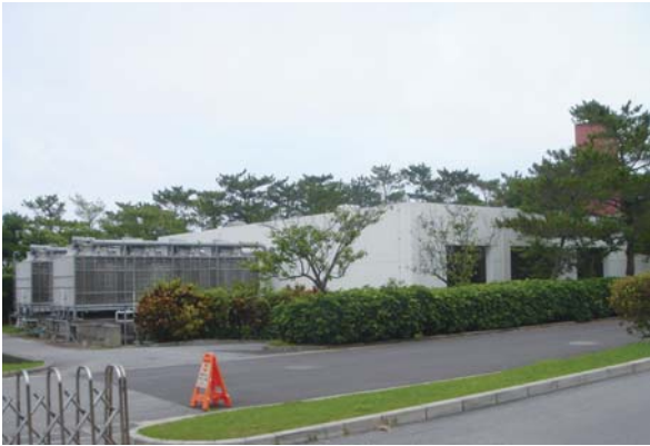
冷水プラント
