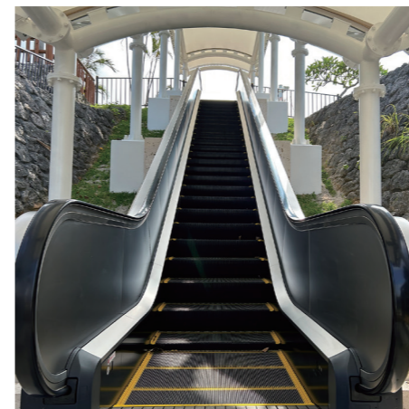
エスカレータ改修
