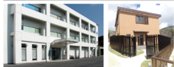
国営沖縄記念公園事務所(本部庁舎) 首里出張所(仮設)
