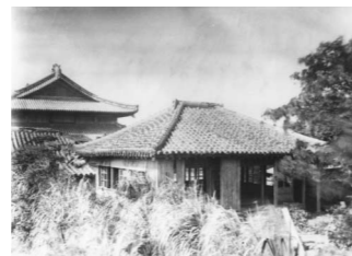
手前が奥書院、奥が正殿(昭和初期撮影)
