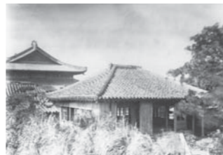
手前が奥書院、奥が正殿（昭和初期撮影）
