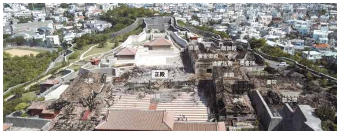
火災後(令和元年11月1日)
