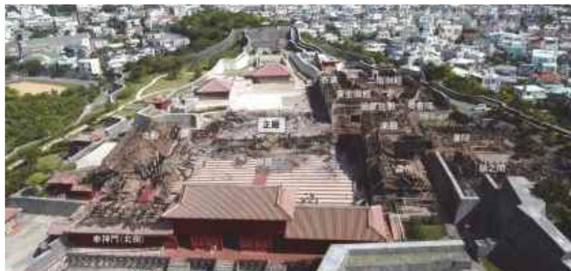
火災後(令和元年11月1日)
