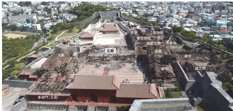
火災後(令和元年11月1日)
