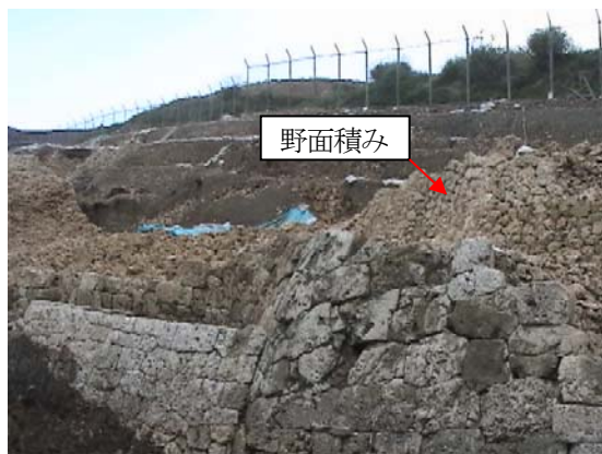
首里城外郭石積（久慶門付近）
