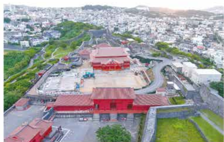
素屋根撤去後(令和7年10月) 素屋根の撤去が完了しました。 正殿の外観が沖縄の空の下に姿を現しました。
