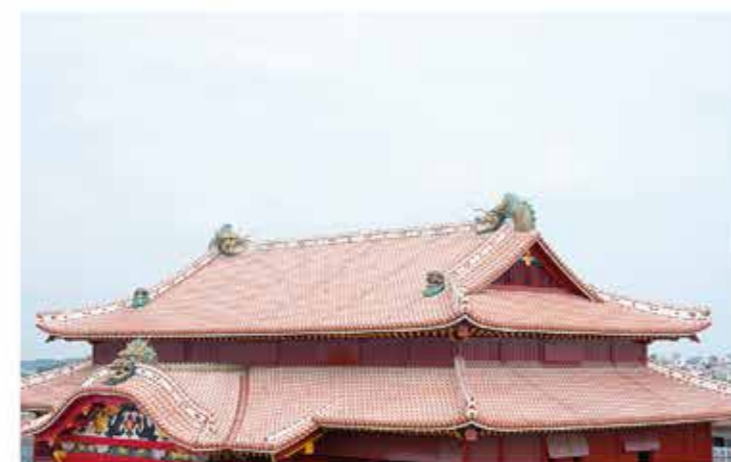
正殿屋根の完成状況(令和7年7月) 鬼瓦や龍頭棟飾、唐破風妻飾の設置が完了しました。
