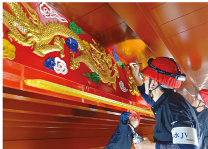
天井額木(正殿2階)の彩色(令和7年10月)
