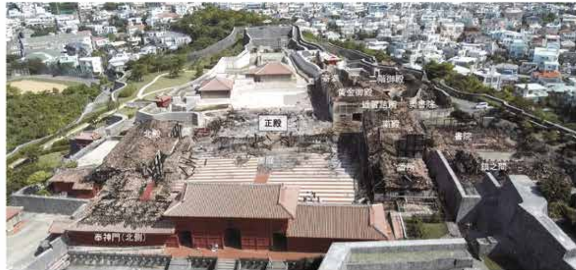
火災後(令和元年11月1日)
