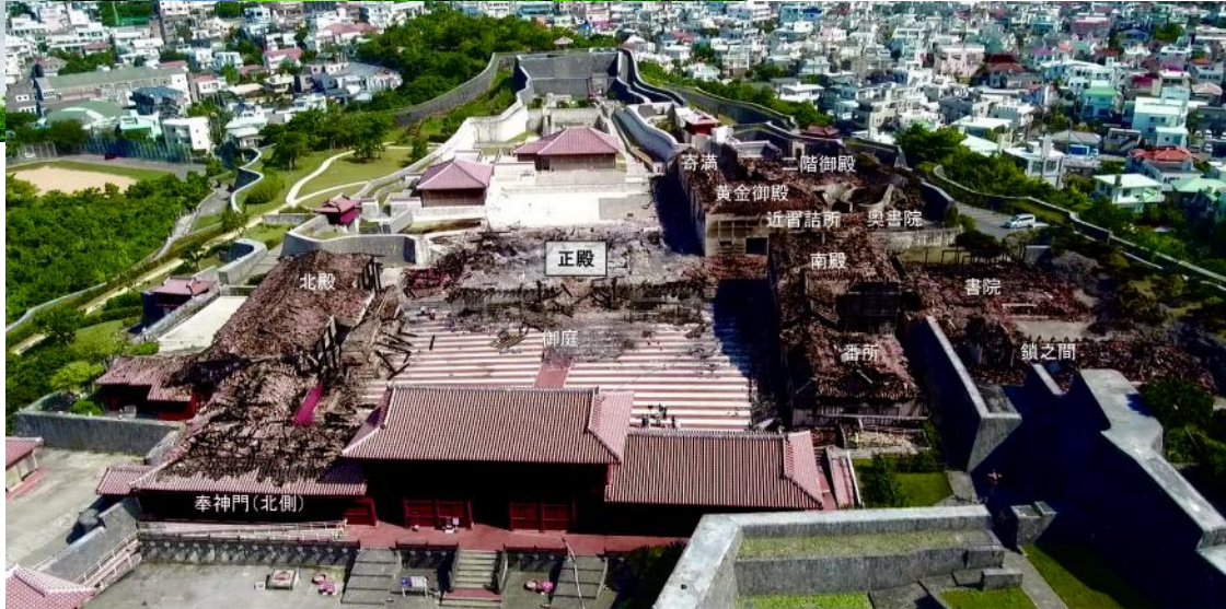
火災後（令和元年11月1日）
