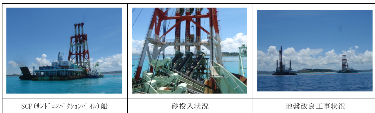
図- 4.1.2 地盤改良工事の状況（平成 26 年 7 月撮影）
