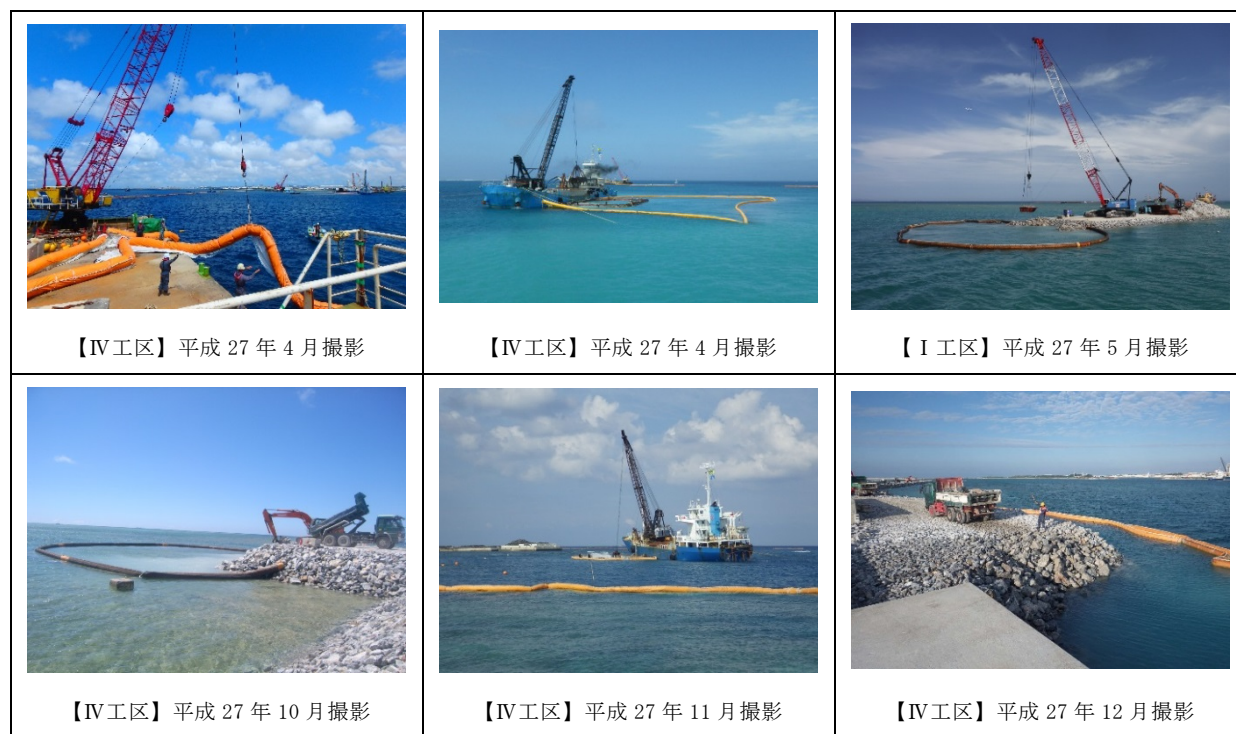
図一 4.1.4 汚濁防止膜の設置状況
