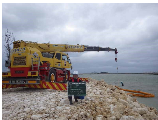
① 汚濁防止膜の設置状況
