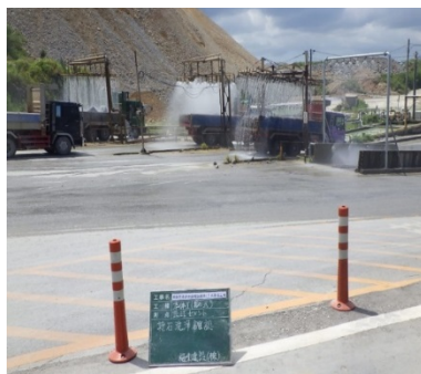
⑤ 石材の洗浄状況(採石場での洗浄)
