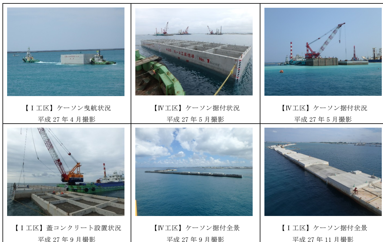
図－ 4.1.10 護岸工事（ケーソン据付）の状況
