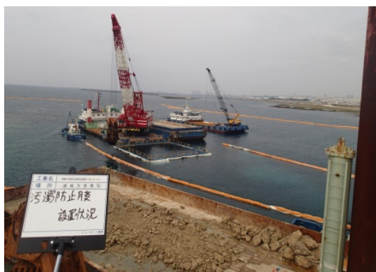
① 汚濁防止膜の設置状況
