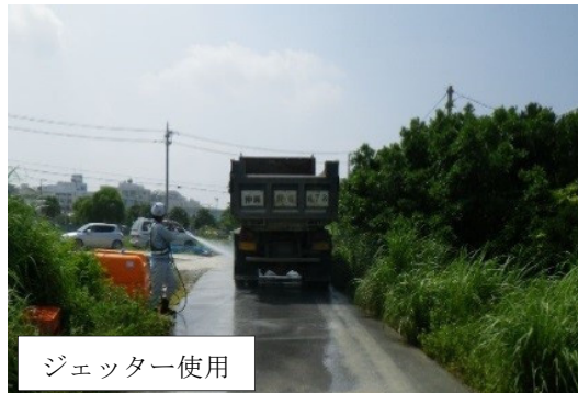
⑥ タイヤ洗浄施設等の設置状況
