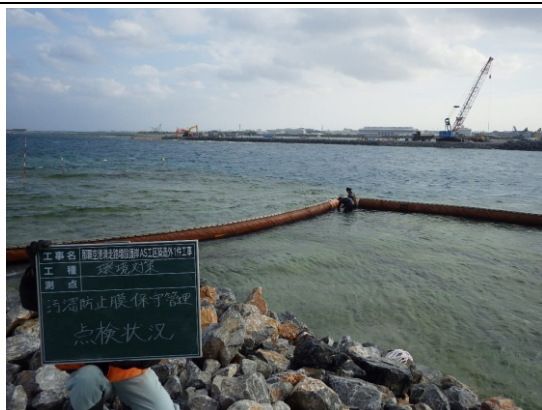
③ 汚濁防止膜の点検・補修状況
