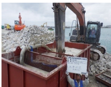
⑤ 石材の洗浄状況(現場にて洗浄タンクで洗浄し、エアブローで石粉除去後投入)
