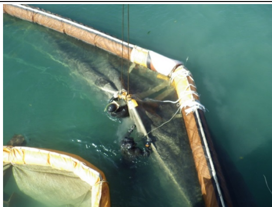
③ 汚濁防止膜の点検・補修状況
