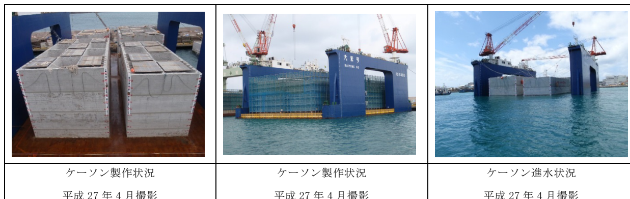
図－ 4.1.9 護岸工事（ケーソン製作）の状況
