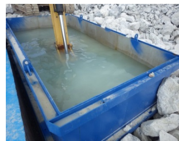
⑤ 石材の洗浄状況(現場にて洗浄タンクで洗浄し、エアブローで石粉除去後投入)
