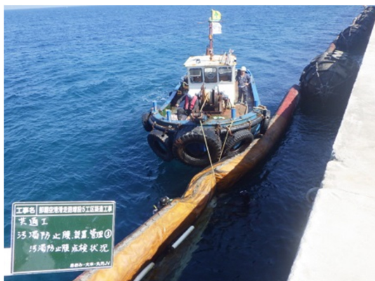
④ 汚濁防止膜の点検・補修状況
