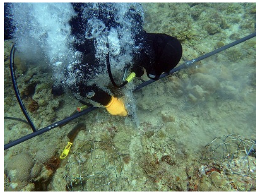
図ー 4.2.42 着床サンゴの種類と数量の確認（左）とエアドリルによる穿孔（右）
