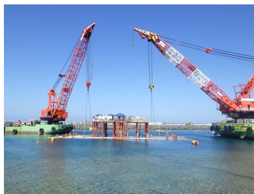
通水カルバート据付状況（V工区）
