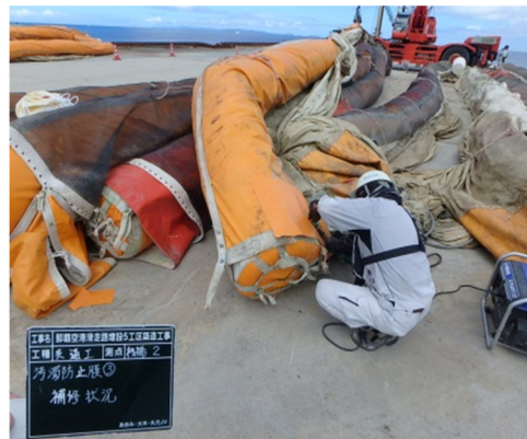
④ 汚濁防止膜の点検・補修状況
