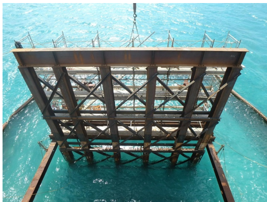
① 汚濁防止膜の設置状況
