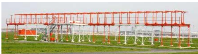
滑走路への進入コースの中心から左右のずれを示すローカライゼ用アンテナ(VHF帯)
