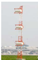
適切な進入角を示すグライド・スロープ用アンテナ(UHF帯)
