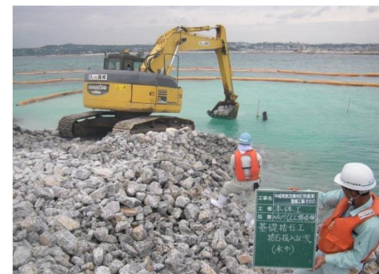
緩傾斜護岸施工イメージ
