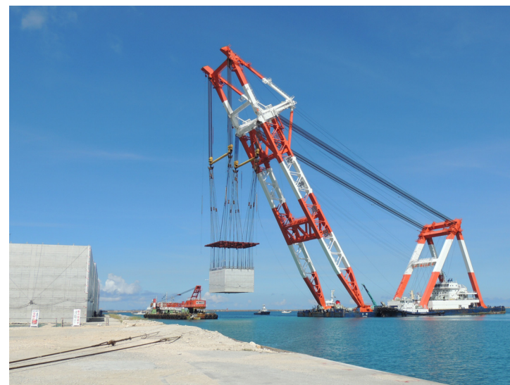
ケーソン吊り降ろし状況（平成 26 年 8 月撮影）
