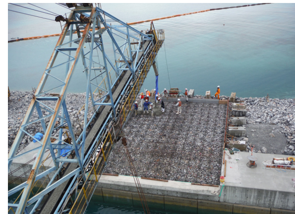
【VI工区】 上部コンクリート打設状況 (平成 26 年 11 月撮影)
