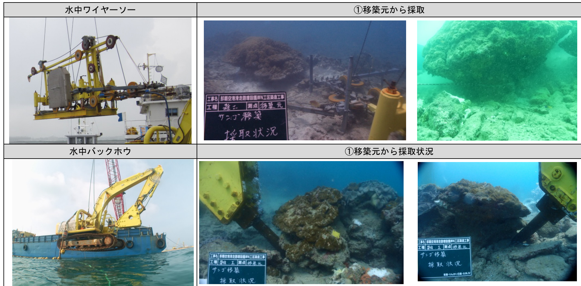
図 19(1) 大型サンゴの移築作業の流れ
