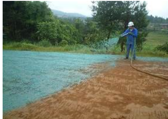
図 3 土壤団粒化剤の吹付作業状況
