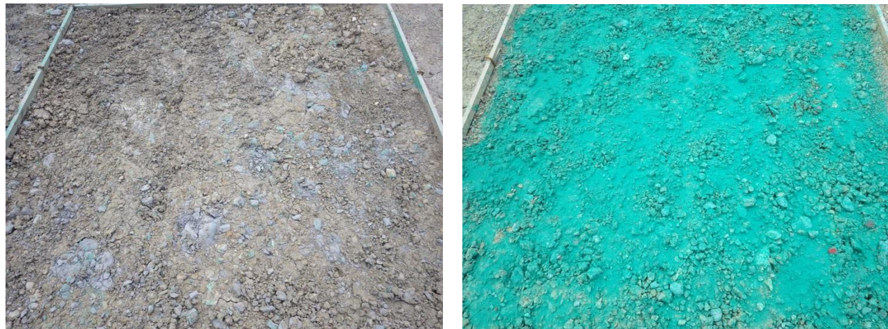
図 4 土壤団粒化剤の吹付状況（左：吹付前、右：吹付後）
