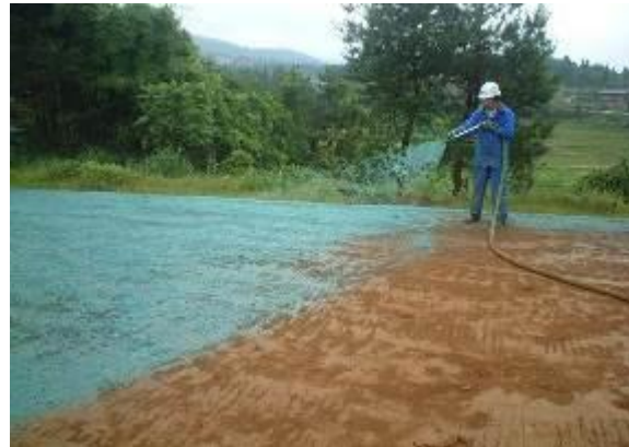
図 3 土壤団粒化剤の吹付作業状況
