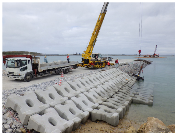
【VI工区】ブロック据え付け状況
