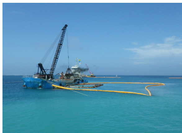
図 3 汚濁防止膜設置状況（平成 27 年 4 月、5 月撮影）
