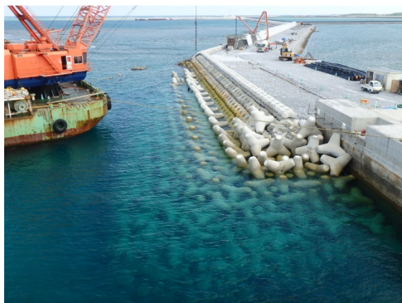
【Ⅰ工区】消波ブロック据付状況
