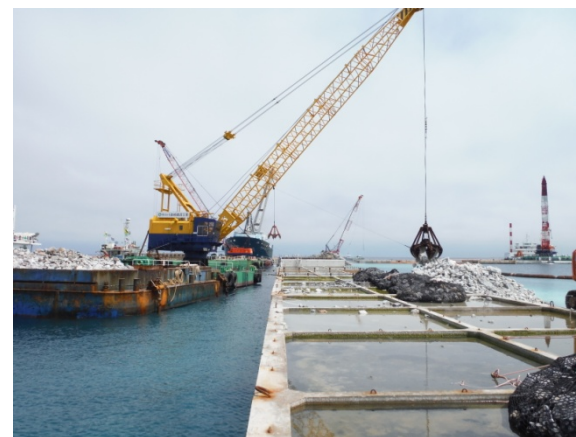
【Ⅳ工区】裏込材投入状況
