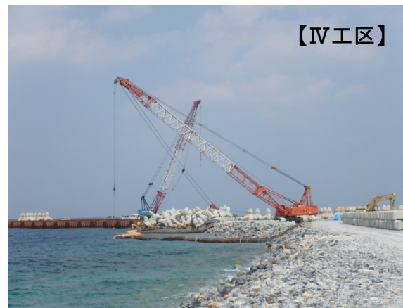
図3 汚濁防止膜設置状況(平成28年4月撮影)
