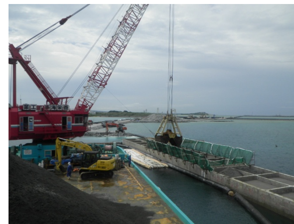
【北側】ケーソン中詰砂投入状況
