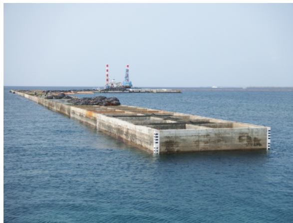
【北側】ケーソン据付状況②
