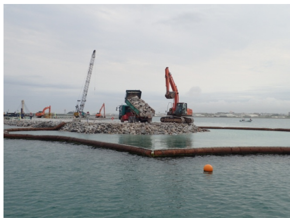
【Ⅰ工区】捨石投入状況
