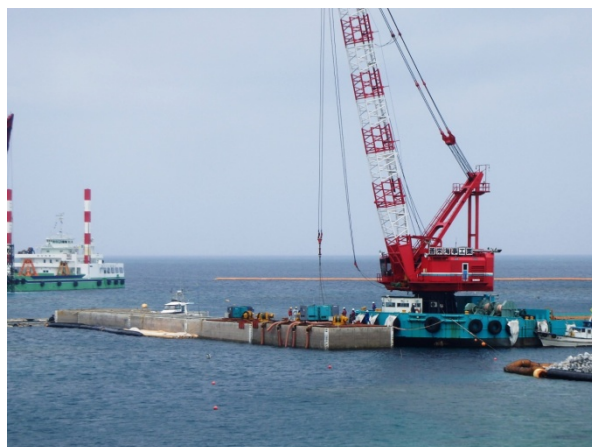
【北側】ケーソン据付状況①
