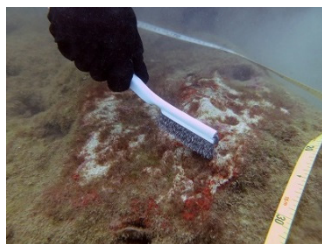
〈ワイヤーブラシによる 基盤面の清掃〉
