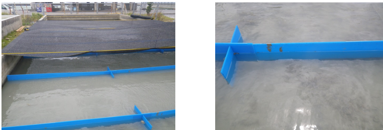
図 35 屋外水槽における改善策の状況
