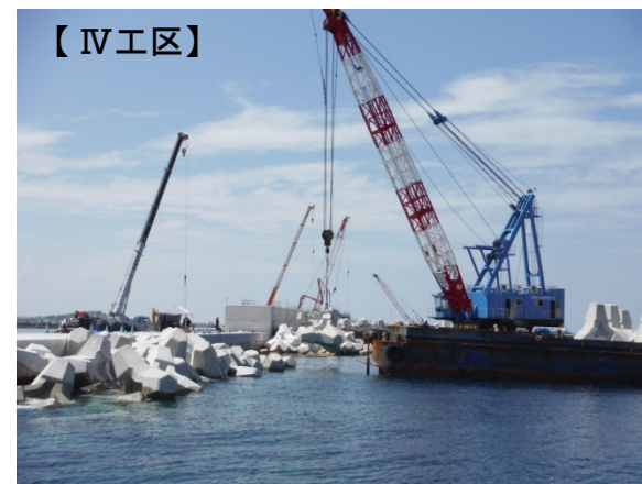
③ 消波ブロック据付状況(平成28年10月撮影)
