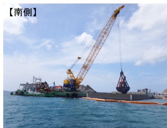
② ケーソン中詰砂投入状況 (平成28年8月撮影)
