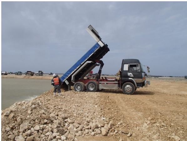
① 【Ⅱ工区】岩ズリ投入状況 (平成29年4月撮影)
