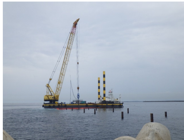
② 北側進入灯工事 杭打設状況 (平成29年5月撮影)
