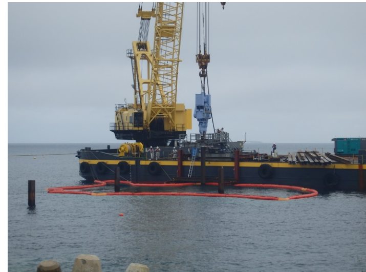
② 【北側進入灯】平成29年5月撮影
