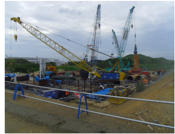
③ 管制塔工事 杭工事施工状況 (平成29年4月撮影)
