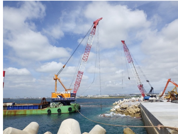
② 【IV工区】被覆ブロック据付状況 (平成29年6月撮影)
