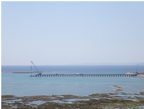
① 南側進入灯工事 作業構台施工状況 (平成29年5月撮影)
