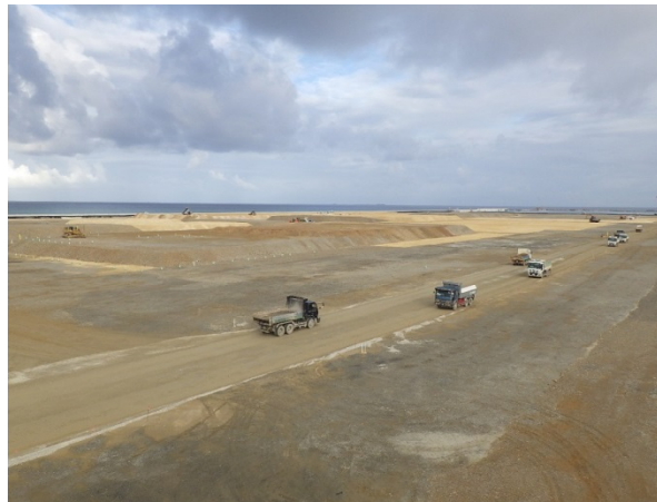
② 【Ⅲ工区】全景 (平成29年1月撮影)
