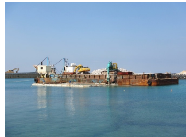
③ 【V工区】通水路部基礎捨石投入状況 (平成29年5月撮影)
