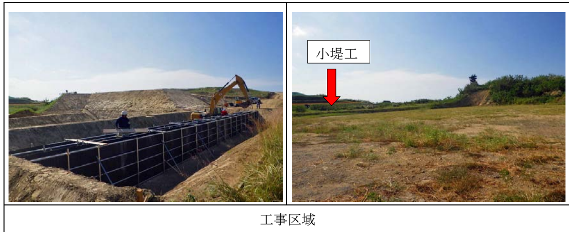
図 79 裸地面を伴う工事に係る濁水等の流入防止対策の実施状況（秋季）
