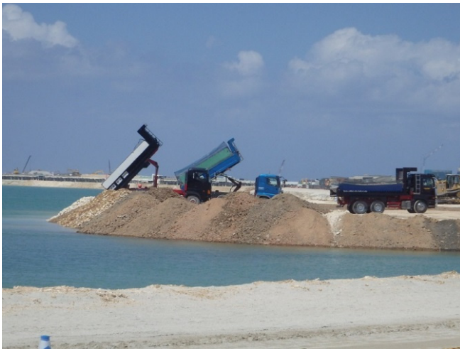
① 【Ⅰ工区】岩ズリ投入状況 (平成30年3月撮影)
