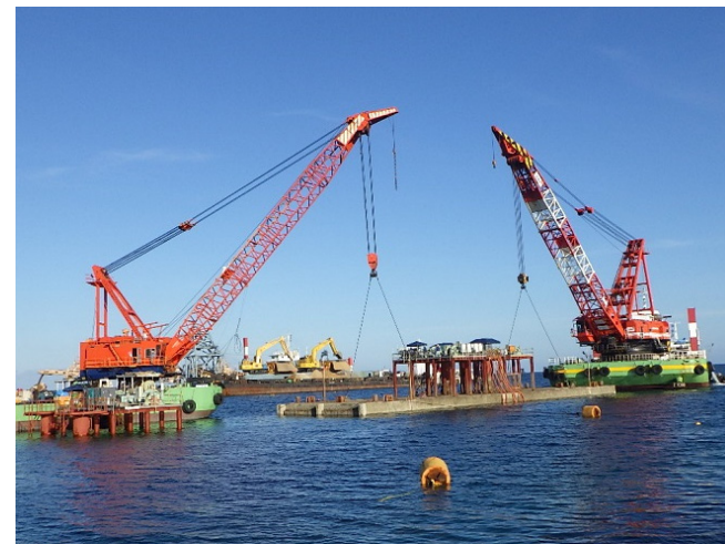
③ 【V工区】通水カルバート据付状況 (平成29年10月撮影) ※平成30年2月通水開始
