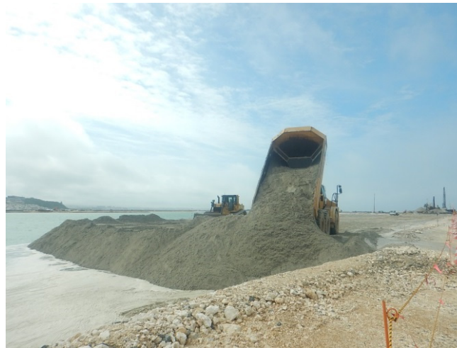
② 【Ⅰ工区】海砂投入状況 (平成30年4月撮影)
