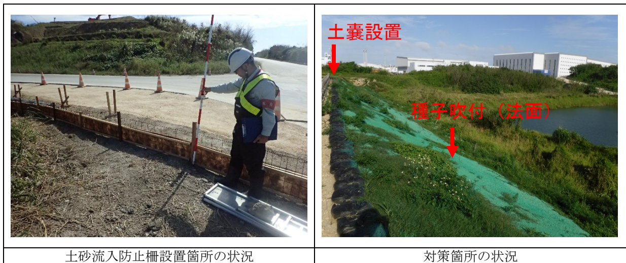
図 97 裸地面を伴う工事に係る濁水等の流入防止対策の実施状況（秋季）
