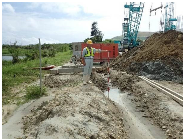
素掘り側溝、土嚢の設置
