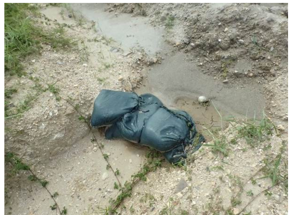
素掘り側溝、土嚢の設置
