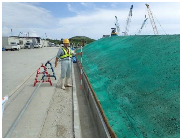
土砂流出防止への設置
