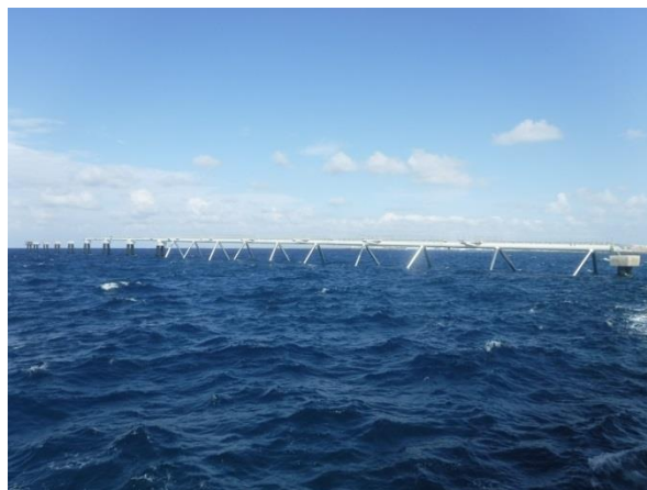
② 北側進入灯工事 橋梁上部工状況 (平成30年11月撮影)
