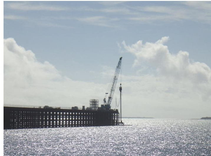
②【南側進入灯】杭打設状況(平成30年12月撮影)
