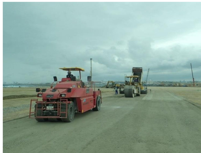
② 【Ⅳ工区】誘導路下層路盤転圧状況 (平成30年12月撮影)
