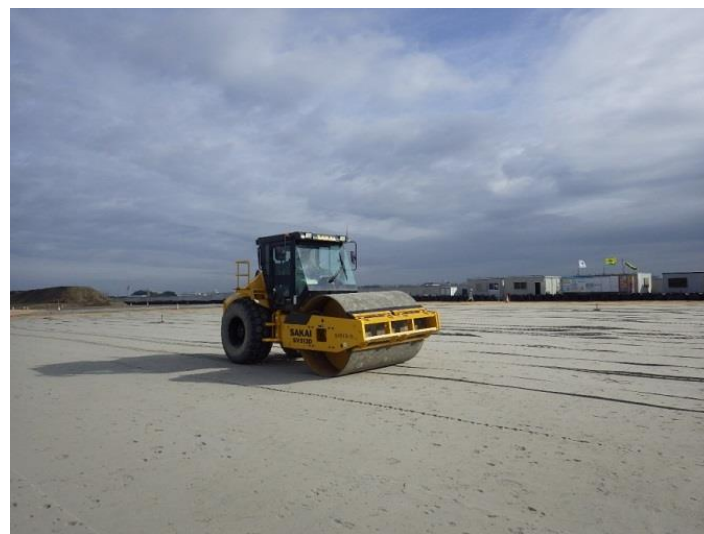
② 【I工区】転圧状況 (平成30年12月撮影)
