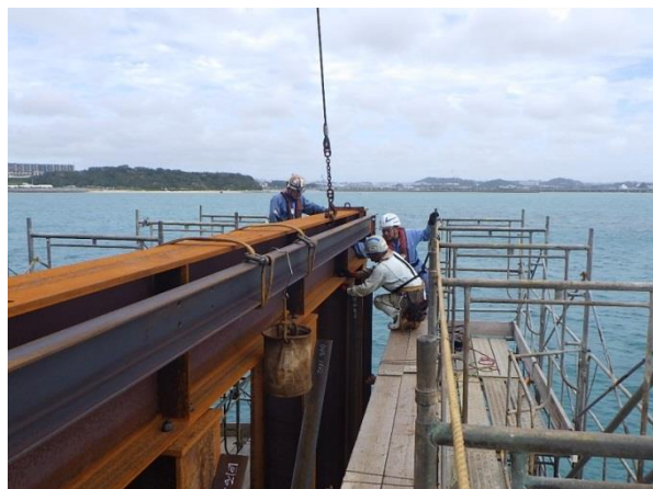
① 南側進入灯工事 仮設構台設置状況 (平成30年12月撮影)
