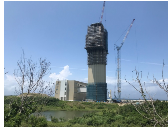
③ 管制塔工事 施工状況 (平成31年4月撮影)
