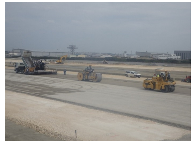
③ 【V・VI工区】下層路盤敷設・転圧状況 (平成31年4月撮影)
