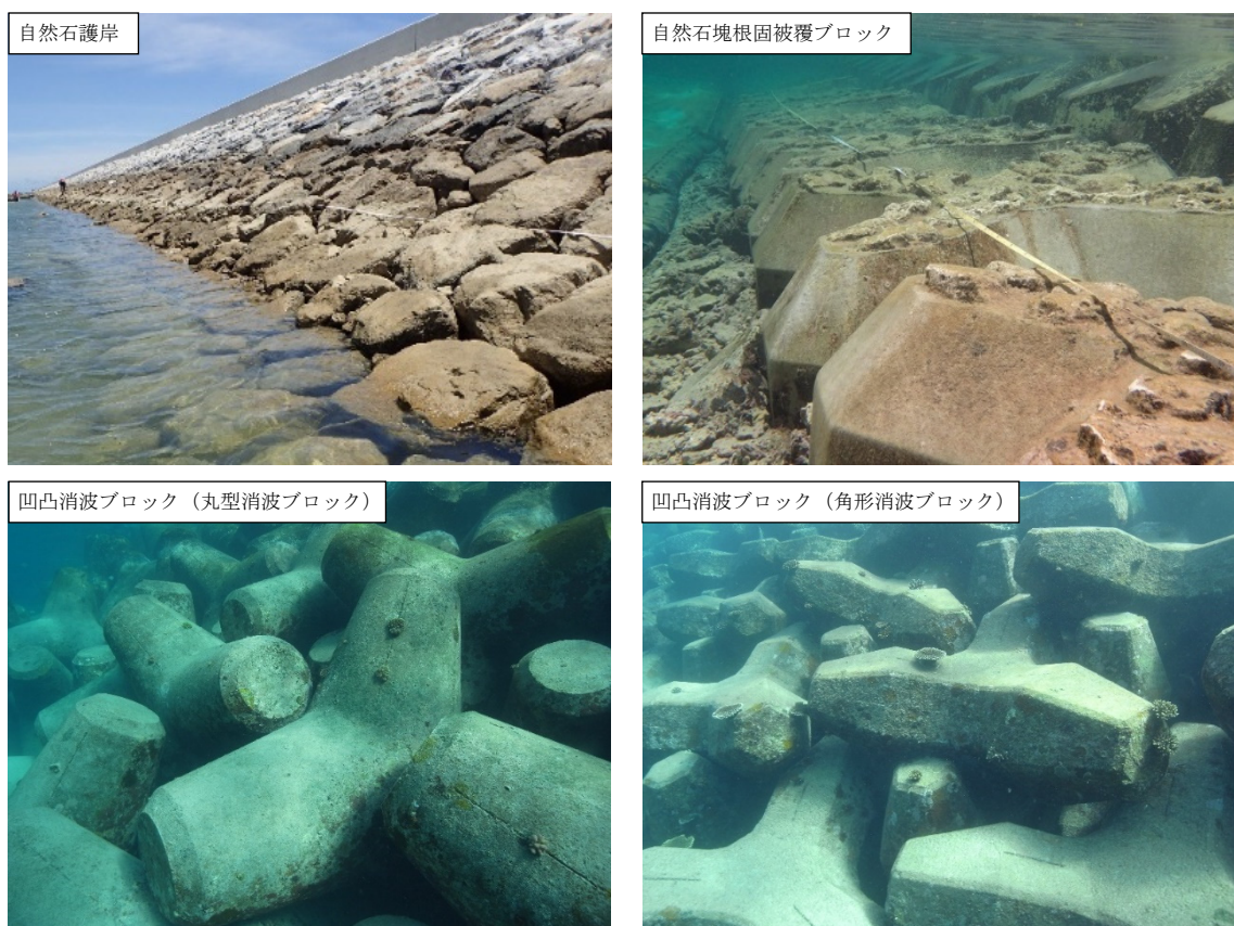
図 46 護岸における環境保全措置実施状況
