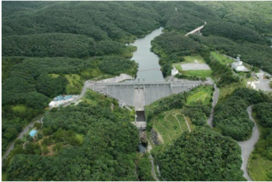
普久川ダム外観
