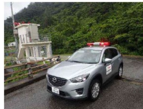
洪水対応演習(R6.4.23~24) 警報吹鳴確認(安波ダム)
