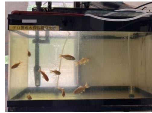
水質監視用の魚水槽(辺野喜ダム管理庁舎内)
