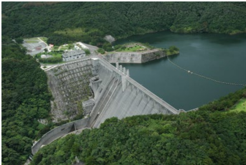
安波ダム外観
