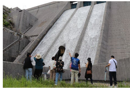
ダム施設見学
