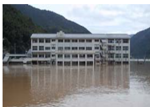
H26.8避難所2階の浸水 (徳島県)
