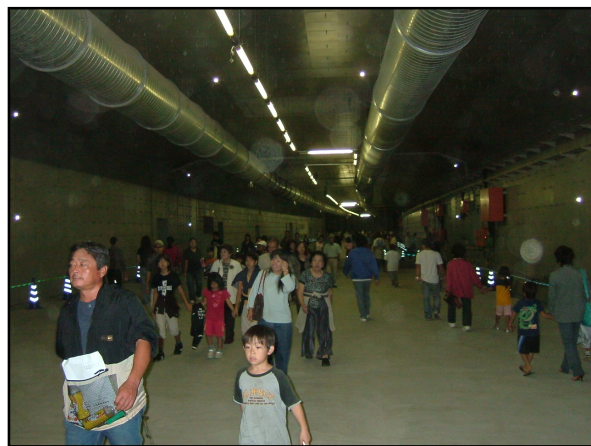
沈埋トンネル内の様子1
