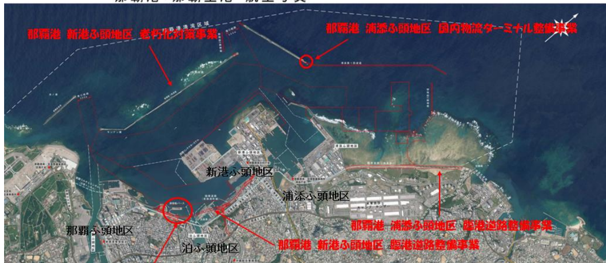
那覇港 泊ふ頭地区 旅客船ターミナル整備事業
