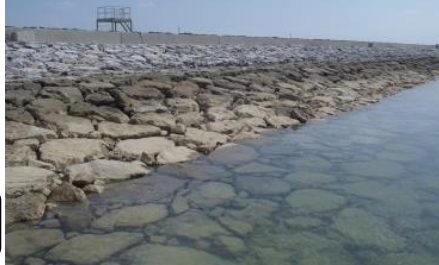
自然石を用いて施工
