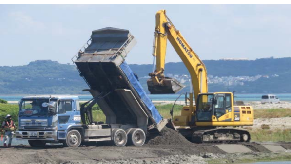
■場内整備工事 海砂投入均し(国施工)
