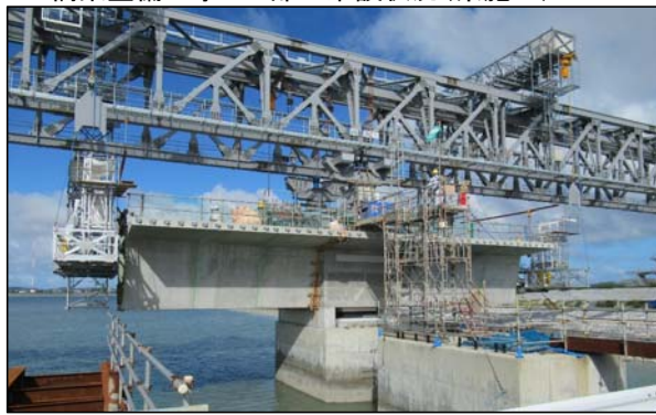
■ 橋梁整備工事 上部工架設状況(県施工)
