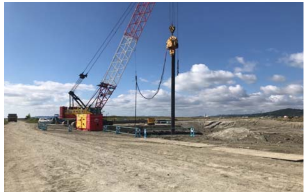
■余水吐鋼矢板引抜き(国施工)
