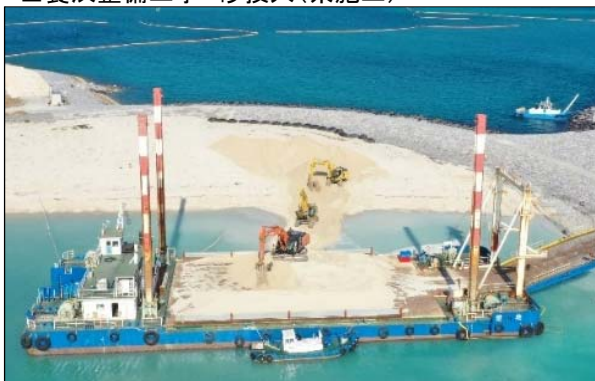
■ 養浜整備工事 砂投入(県施工)
