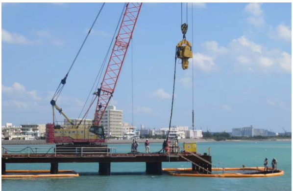
■汚濁防止膜設置 仮設橋梁撤去工事(国施工)
