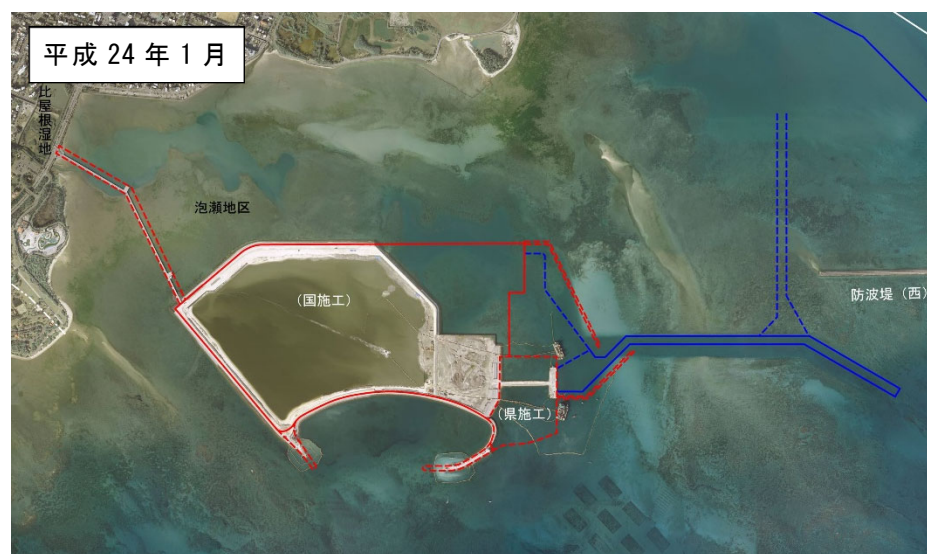
図 3.1.1(5) 泡瀬地区の航空写真
