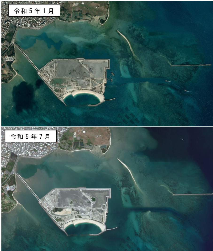
図 3.1.1(9) 泡瀬地区の航空写真
