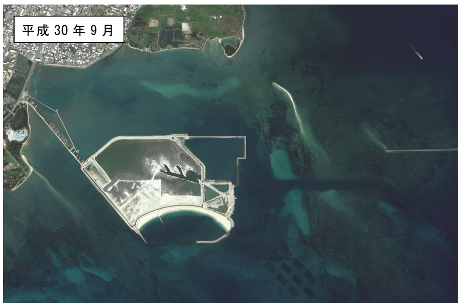
図 3.1.1(7) 泡瀬地区の航空写真
