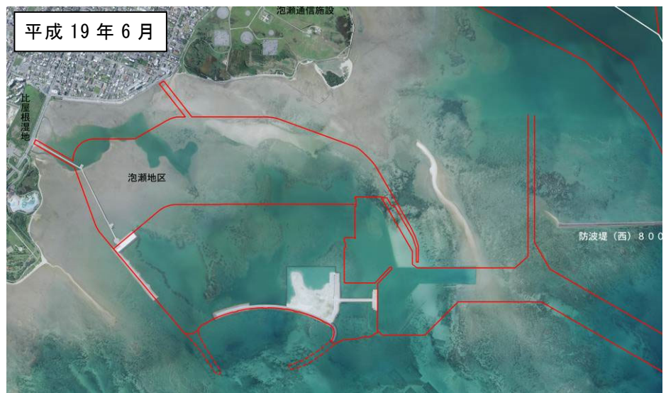
図 3.1.1(4) 泡瀬地区の航空写真
