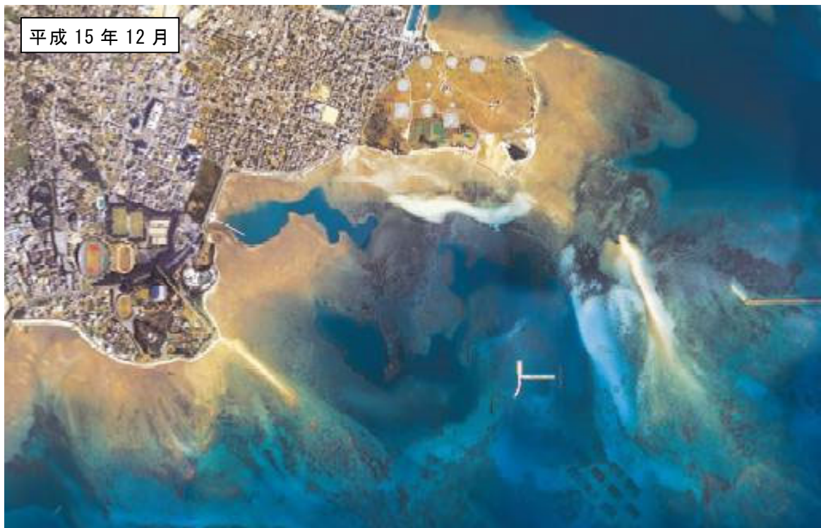
図 3.1.1(3) 泡瀬地区の航空写真
