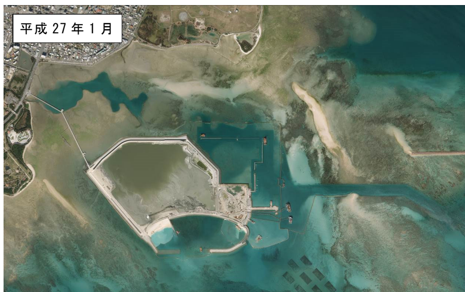
図 3.1.1(6) 泡瀬地区の航空写真
