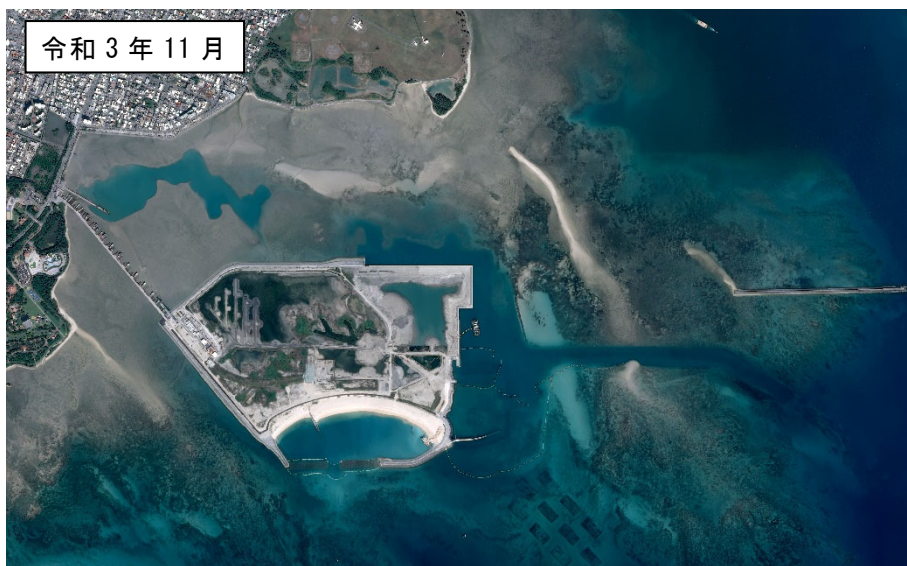
図 3.1.1(8) 泡瀬地区の航空写真
