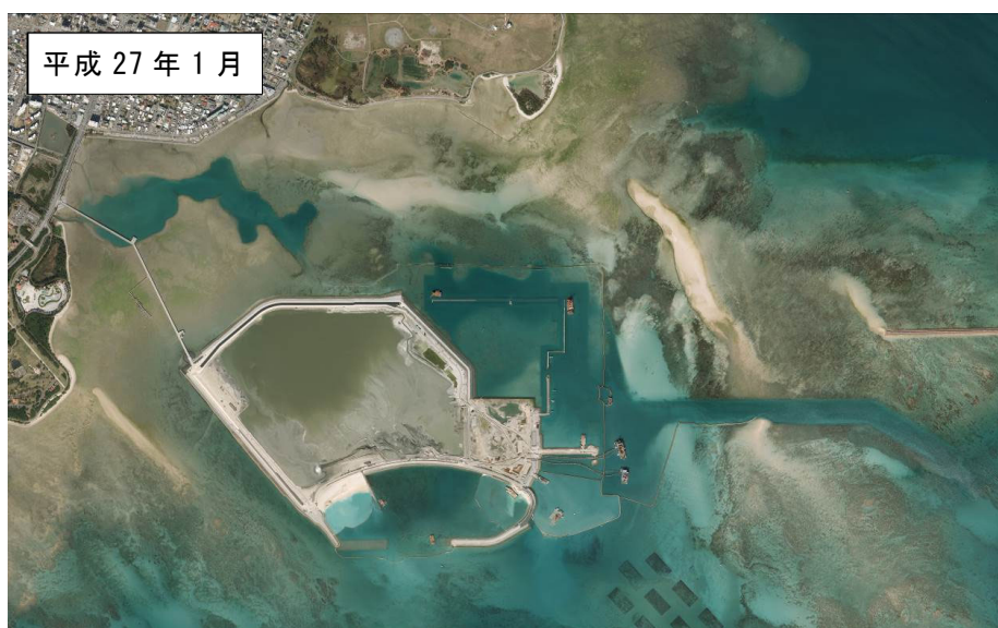
図 3.1.1(6) 泡瀬地区の航空写真
