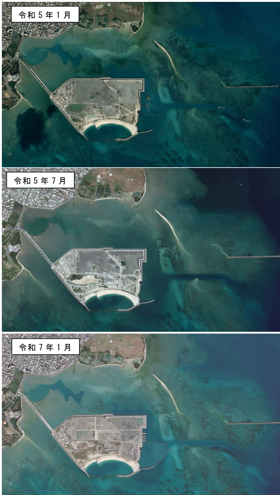
図 3.1.1(9) 泡瀬地区の航空写真
