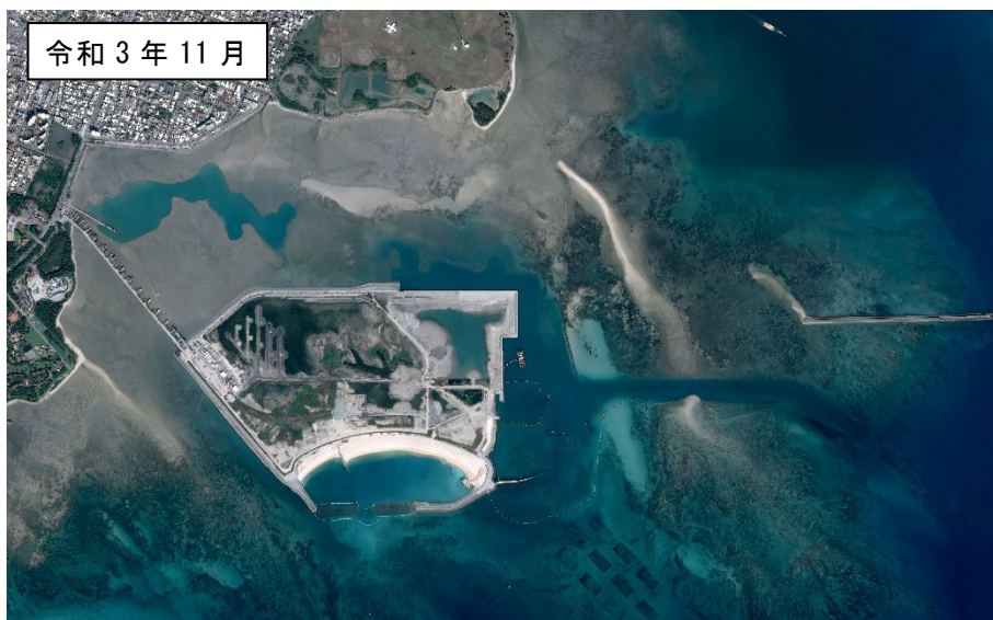
図 3.1.1(8) 泡瀬地区の航空写真
