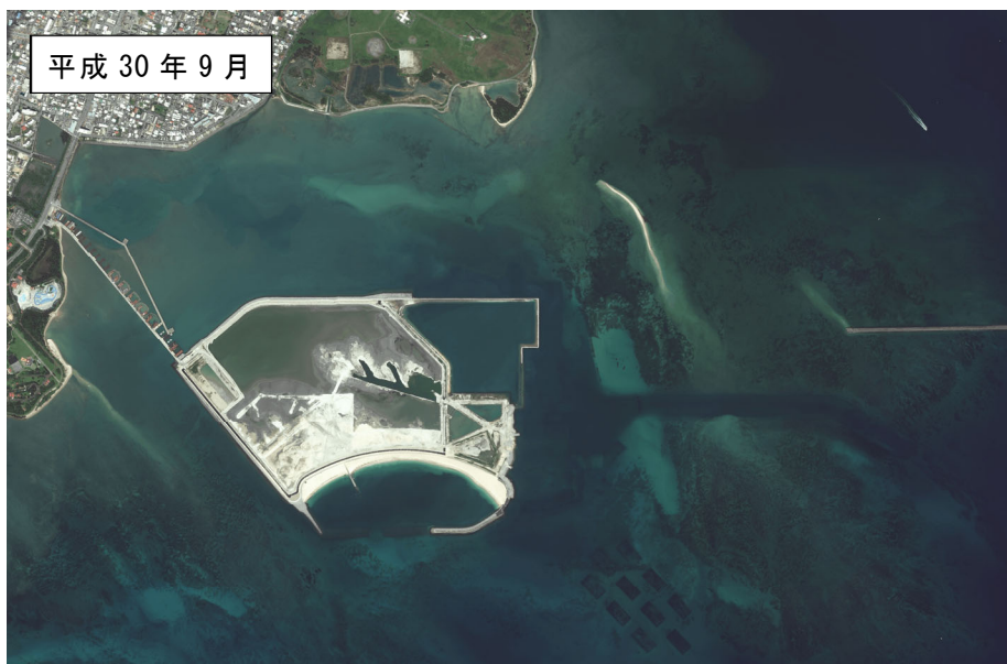
図 3.1.1(7) 泡瀬地区の航空写真
