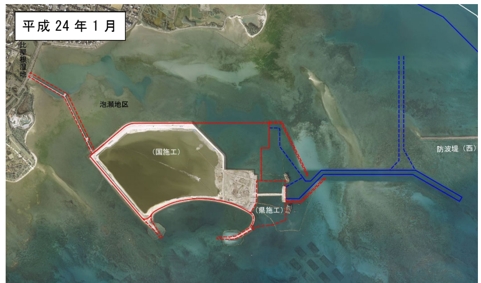
図 3.1.1(5) 泡瀬地区の航空写真
