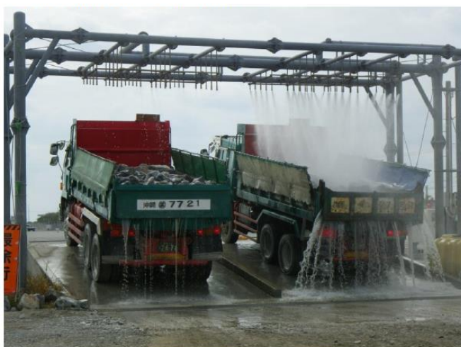
濁り対策 (石材の洗浄)
