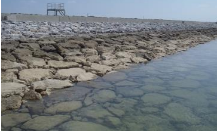
自然石を用いて施工
