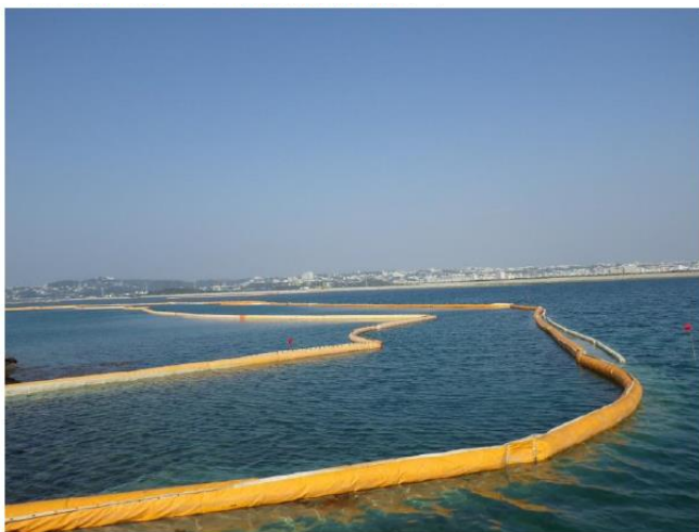
濁り対策 (汚濁防止膜の展張)
