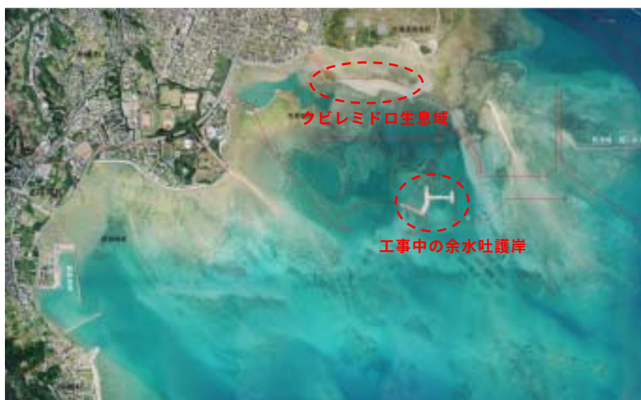
図 2.6.13 クビレミドロ生息域と工事中の余水吐護岸との位置関係
