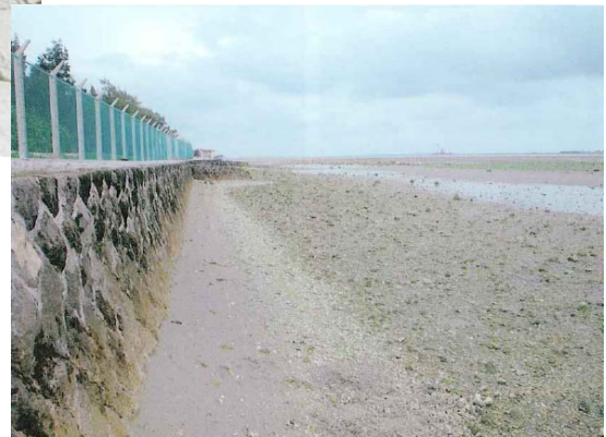
図 3.7 直立護岸(米軍通信基地付近)
